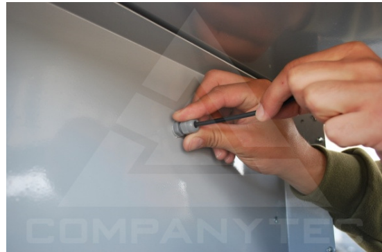
Figura 15 - Após a instalação do IDF05 sensor Hart gire a bucha de aperto até que o cabo fique bem firme
