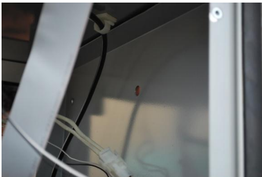
Figura 10 - Furo da chapa interna com 12,5 mm de diâmetro.
