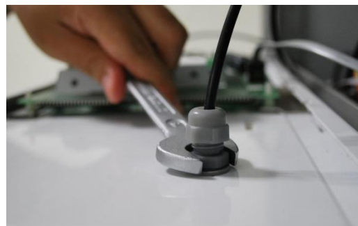
Figura 19 - Aperto da porca do prensa cabo.
