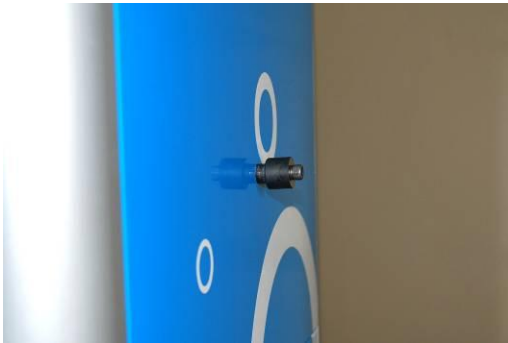
Figura 7 - Realizando o furo
