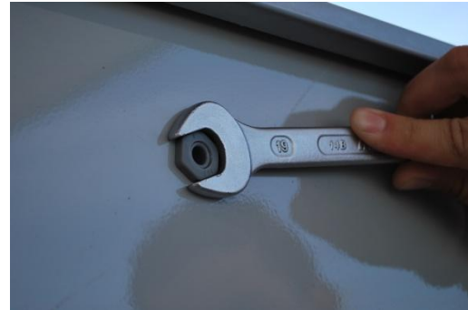
Figura 12 - Fixação do prensa cabo com contra porca entre as duas chapas.
