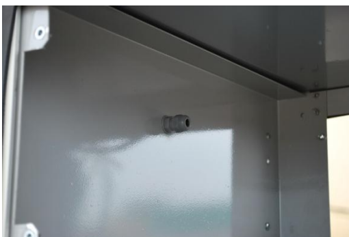
Figura 11 - Colocação do prensa cabo na chapa interna.
