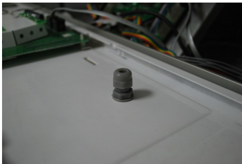
Figura 17 - Colocação do prensa cabo na chapa interna.
