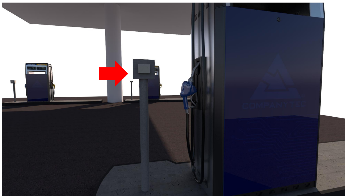
Figura 23 – Totem para instalação do Sensor.
