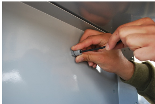
Figura 15 - Após a instalação do sensor gire a bucha de aperto até que o cabo fique bem firme.
