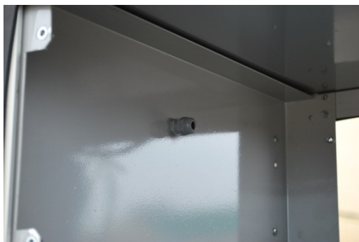
Figura 11 - Colocação do prensa cabo na chapa interna.
